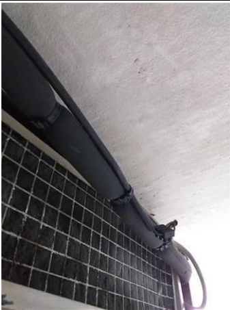
Photo n° PhA012 Localisation : Rez de jardin - Pièce 17 Ouvrage : 8 - Équipements divers et accessoires - Chaudières (mixtes, collectives), chauffe bains, radiateurs gaz modulables, Poêles à bois à fuel, à charbon, Groupes électrogènes Partie d'ouvrage : Calorifugeage climatisation Description : Calorifugeage climatisation
