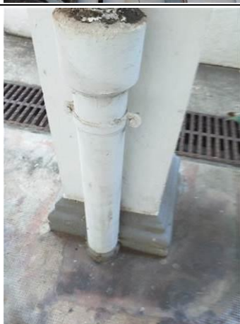
Photo n° PhA003 Localisation : Rez de jardin - Coursive 1; Rez de jardin - Façade droite; Rez de chaussée - Façade droite; 1er étage - Façade droite Ouvrage : 2 - Parois verticales extérieures et Façades - Éléments associés aux façades Partie d'ouvrage : Conduit d'eaux pluviales fibro Description : Conduit d'eaux pluviales fibro
