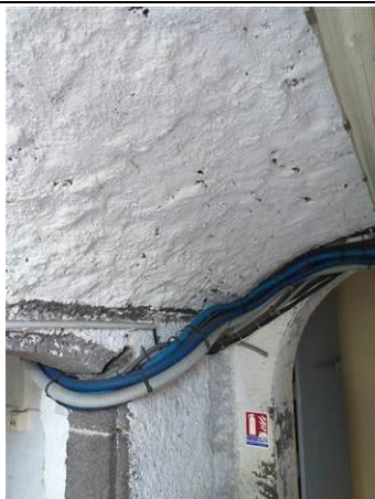
Photo n° PhA008 Localisation : Rez de jardin - Pièce 11 Ouvrage : 3 - Parois verticales intérieures - Murs et cloisons maçonnés Partie d'ouvrage : Enduit à base de ciment projeté Description : Enduit à base de ciment projeté (blanc)
