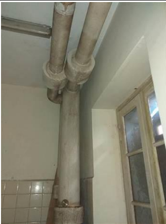
Photo n° PhA011 Localisation : Combles Ouvrage : 8 - Équipements divers et accessoires - Chaudières (mixtes, collectives), chauffe bains, radiateurs gaz modulables, Poêles à bois à fuel, à charbon, Groupes électrogènes Partie d'ouvrage : Calorifugeage Description : Calorifugeage (blanc)
