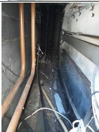
Photo n° PhA015 Localisation : Rez de jardin - Vide sanitaire Ouvrage : 8 - Équipements divers et accessoires - Chaudières (mixtes, collectives), chauffe bains, radiateurs gaz modulables, Poêles à bois à fuel, à charbon, Groupes électrogènes Partie d'ouvrage : Calorifugeage Description : Calorifugeage (noir)
